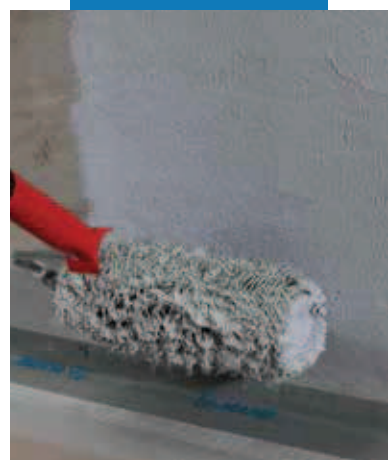
Nanoszenie warstwy Mapegum WPS wałkiem
