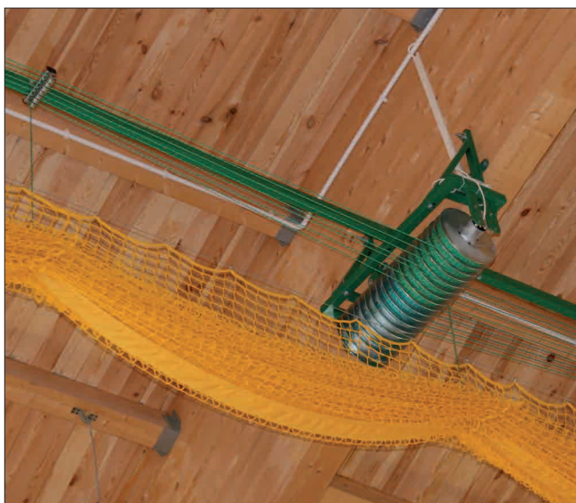
Zespół silnika do podnoszenia materiału kotary
