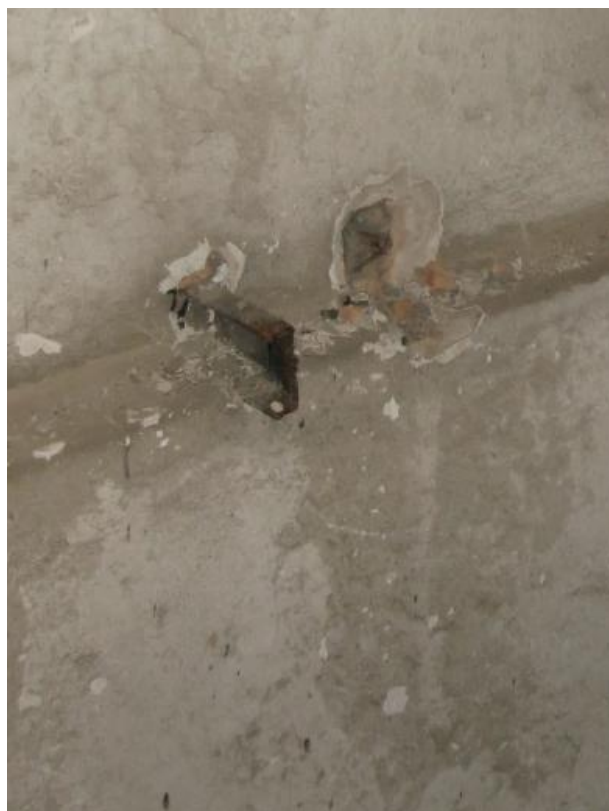
Zdjęcie 27 Fragmenty stalowych belek wystające ze ściany w miejscu przewężenia grubości ściany zewnętrznej
