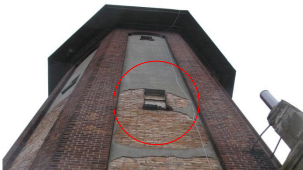
Zdjęcie 5 Ubytki cegieł w parapetach okiennych
