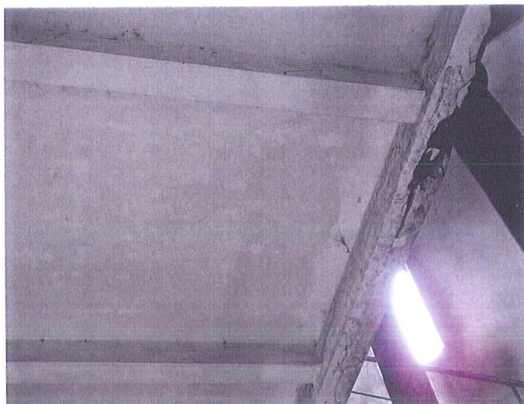
fot.29. Trzon wieży – III kondygnacja. Strop żelbetowy monolityczny nad III kondygnacją. W podciągu odspojona otulina, pręty zbrojenia są głęboko skorodowane.
