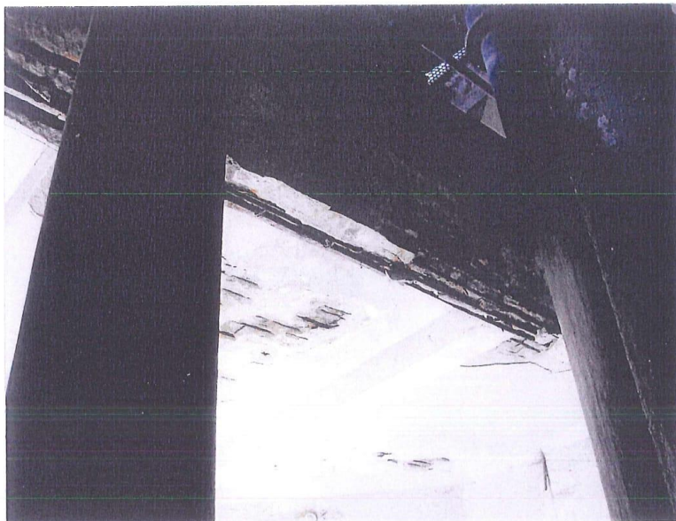
fot.25. Trzon wieży – IV kondygnacja. Strop żelbetowy monolityczny nad IV kondygnacją. Widoczne ubytki otuliny i głęboko skorodowane pręty zbrojenia w płycie i podciągu.
