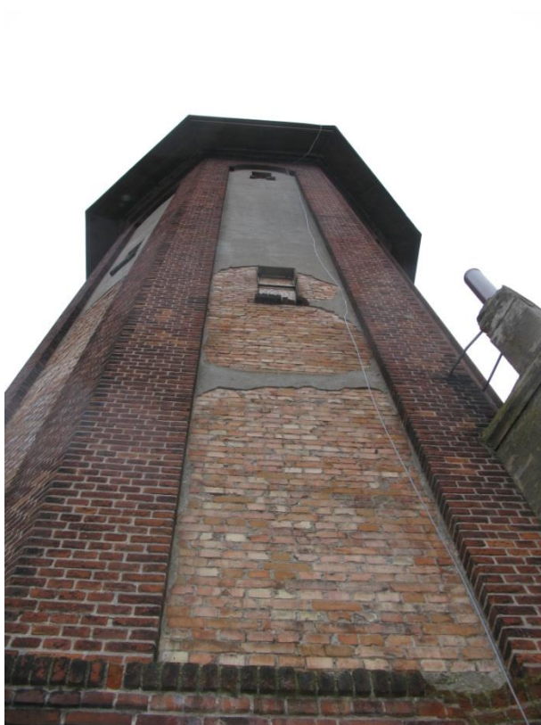
Zdjęcie 19 Ubytki tynku w płycinach elewacji
