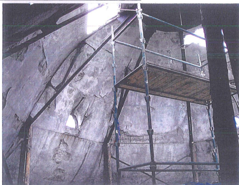
fot.8. Dach nad głowicą wieży. Widoczne więzary stalowe nitowane, oparte na stalowych słupach, na których również jest oparty zbiornik. Słupy są posadowione na koronie ścian trzonu wieży, słupy są powierzchniowo skorodowane. Widoczne zniszczenia betonu zbrojonego.
