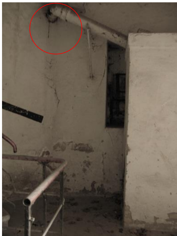
Zdjęcie 23 Otwory w murze wykonane do poprowadzenia instalacji ogrzewania
