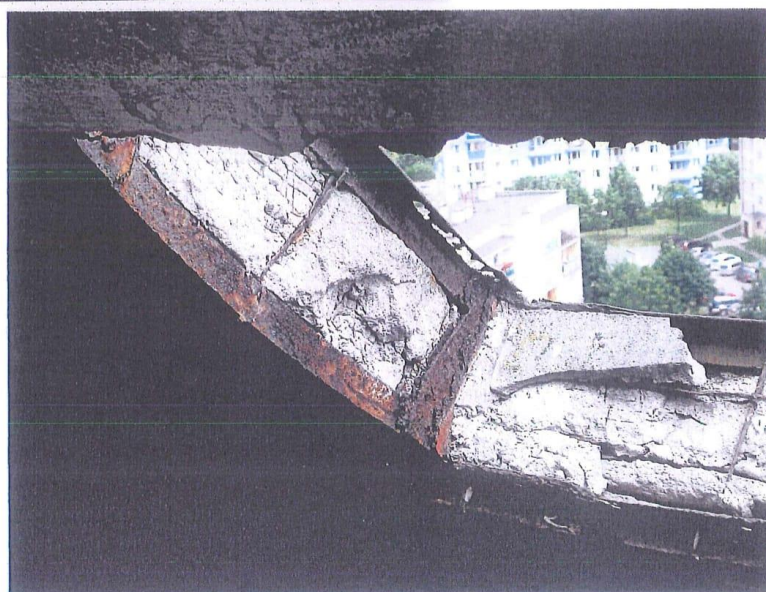
fot.12. Dach nad głowicą wieży. Stalowa obudowa otworu okiennego jest całkowicie skorodowana z ubytkami. Beton jest spękany, porowaty, a zbrojenie głęboko skorodowane.
