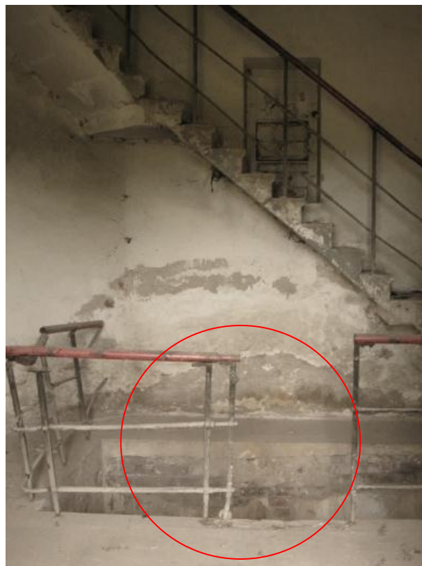
Zdjęcie 22 Szyb w podłodze parteru
