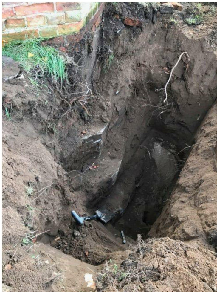
Zał. 6a. Fotografia odkrywki fundamentu wieży ciśnień
