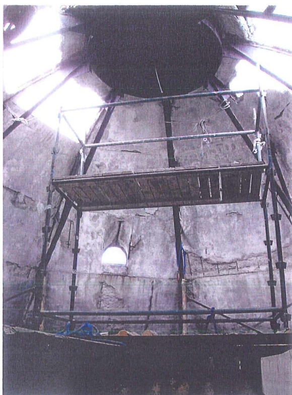
fot.7. Dach nad głowicą wieży. Widoczne więzary stalowe niosące stalowy element centralny, na którym jest posadowiony hełm z latarnią. Powłoka dachu jest wykonana z betonu zbrojonego.
