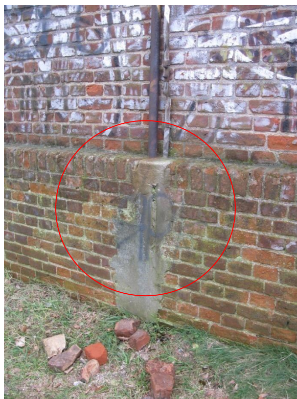
Zdjęcie 8 Ubytki w ceglany cokole powstałe w wyniku zamontowania na elewacji instalacji elektroenergetycznej
