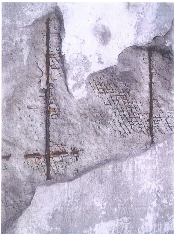
fot.13. Dach nad głowicą wieży. Rozległy ubytek powłoki betonowej, zbrojenie jest skorodowane. Widoczna siatka stalowa z prętów \Phi 1 mm, o rozstawie 13/13 mm, ułożona po stronie zewnętrznej zbrojenia.
