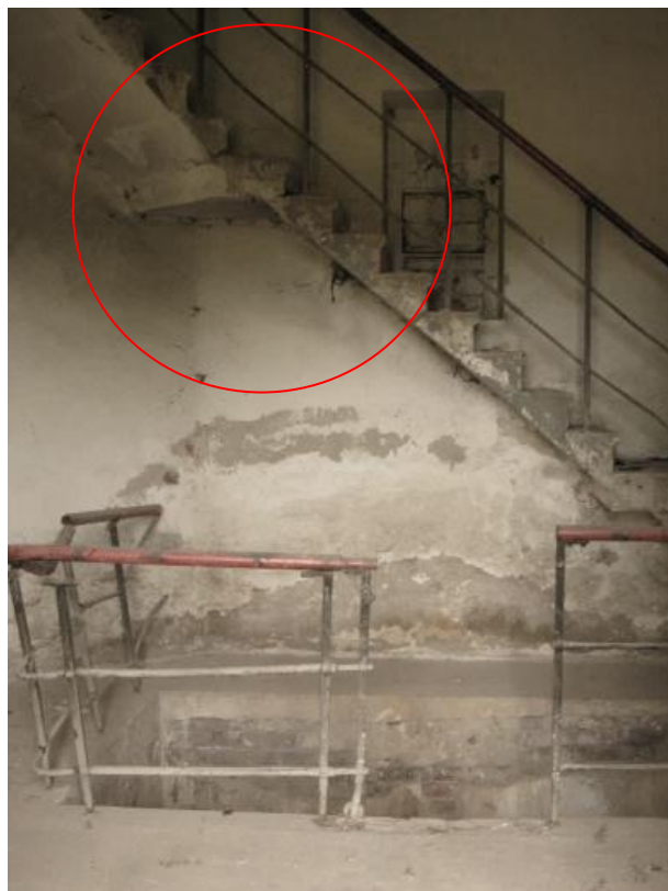
Zdjęcie 21 Schody w złym stanie technicznym, niespełniające przepisów ppoż.
