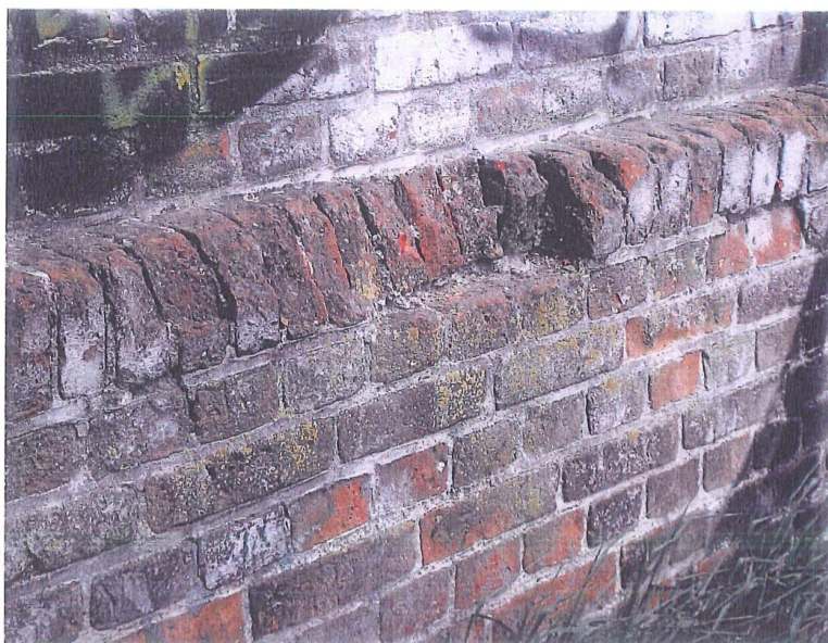
fot.43. Odsadzka zewnętrznego cokołu na I kondygnacji (na parterze) wieży. Widoczne cegły głęboko skorodowane z głębokimi ubytkami. W ścianie na ogół nie ma głębokich ubytków zaprawy.
