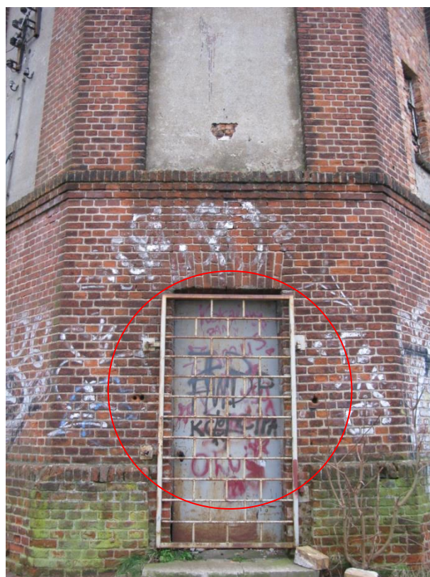
Zdjęcie 20 Ślusarka drzwiowa w złym stanie technicznym
