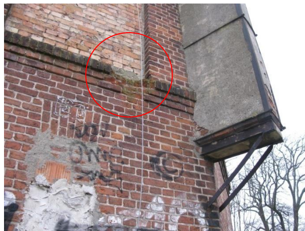
Zdjęcie 4 Zniszczony ceglany gzyms - skutek otarcia kablem odgromowym
