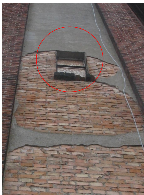
Zdjęcie 16 Brak stolarki okiennej, okna zabudowane płytami OSB
