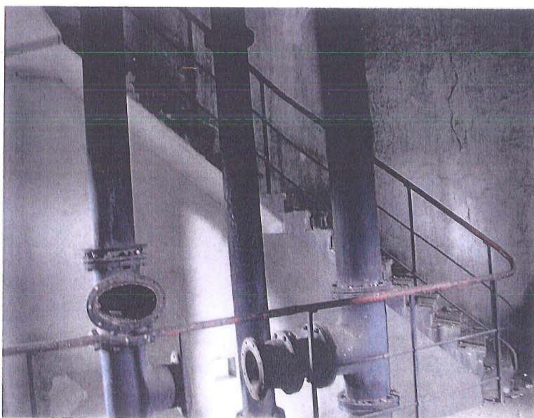
fot.26. Trzon wieży – IV kondygnacja. Na ścianie południowo-wschodniej widoczne pionowe zarysowanie o niewielkiej rozwarłości. Schody 3-biegowe o stopniach wspornikowych żelbetowych prefabrykowanych Schody szerokości całkowitej 83 cm, bez większych uszkodzeń. Balustrada stalowa wysokości 96-102 cm.
