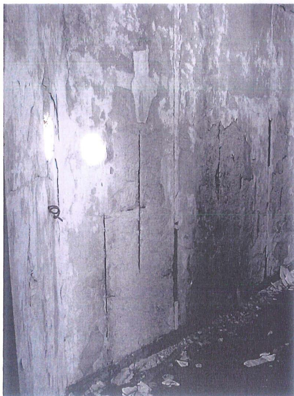
fot.18. Pośrednia partia ścian głowicy wieży. W ścianach widoczne otwory. Na ścianie ubytki otuliny i pręty głęboko skorodowane.
