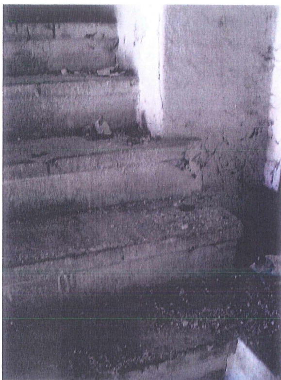
fot.39. Trzon wieży – I kondygnacja (parter). Fragment schodów przy ścianie wschodniej. Widoczne stopnie wspornikowe nie zamocowane w miejscu wneki w ścianie.
