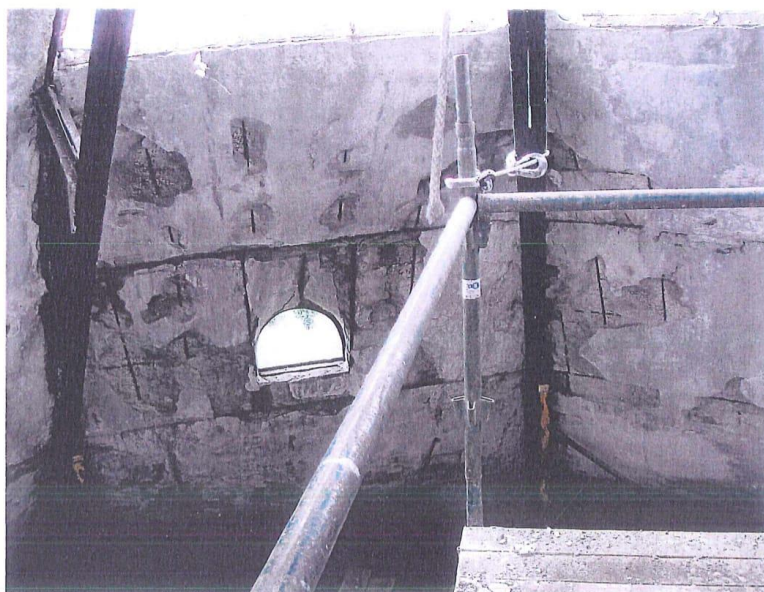
fot.9. Dach nad głowicą wieży. Widoczne zniszczenia betonu zbrojonego – rozległe odspojenia otuliny prętów i warstw od strony wnętrza wieży. Pręty zbrojenia pionowe i poziome o znacznym rozstawie są głęboko skorodowane.
