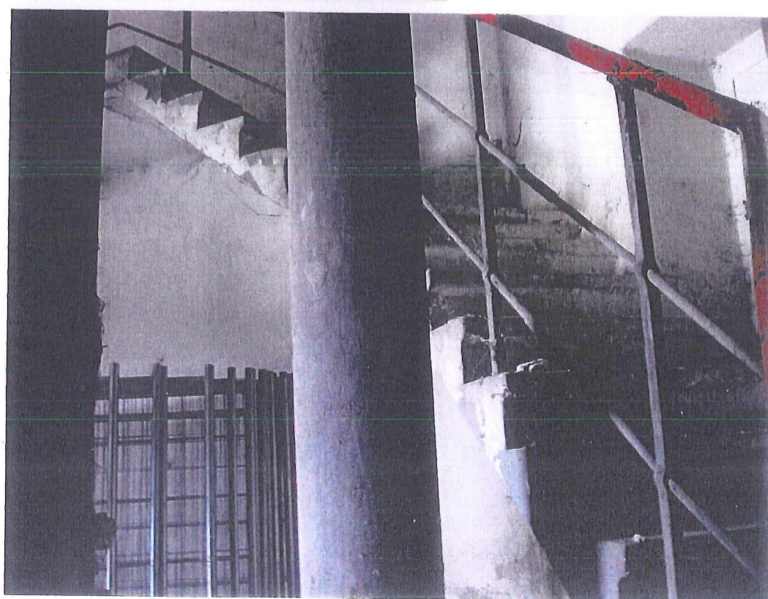
fol.38. Trzon wieży – I kondygnacja (parter). Schody 3-biegowe o stopniach wspornikowych żelbetowych prefabrykowanych. W schodach nieliczne uszkodzenia z ubytkami naroży stopnic.
