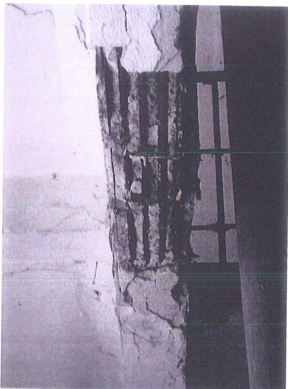
fol.37. Trzon wieży – I kondygnacja (parter). Podciąg stropu żelbetowego nad I kondygnacją - zbliżenie z fol.36. Widoczny rozległy ubytek otuliny, pręty zbrojenia głęboko skorodowane.
