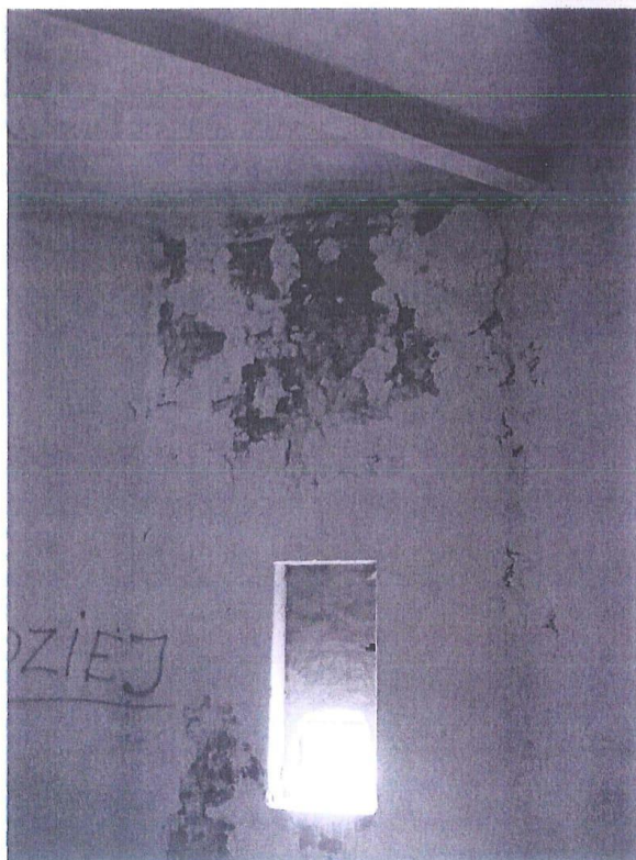
fot.32. Trzon wieży – II kondygnacja. Na ścianie południowo-zachodniej, góra i dół, ciemne ślady zawilgocenia.
