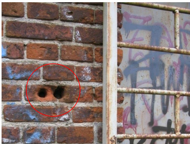
Zdjęcie 3 Ubytki cegieł w elewacji
