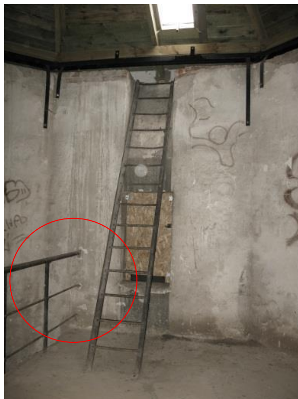
Zdjęcie 24 Bariery schodowe wbite w ściany
