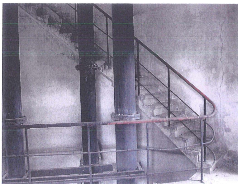
fot.30. Trzon wieży – III kondygnacja. Na ścianie południowo-wschodniej widoczne pionowe zarysowanie o niewielkiej rozwartości. Schody 3-biegowe o stopniach wspornikowych żelbetowych prefabrykowanych. W schodach nieliczne uszkodzenia z ubytkami naroży stopnic.
