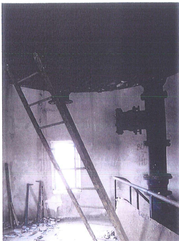
fot.23. Trzon wieży – V kondygnacja. widoczny spód zbiornika wody. Ściany trzonu od wnętrza są otynkowane.- tynki bez spękań i ubytków.
