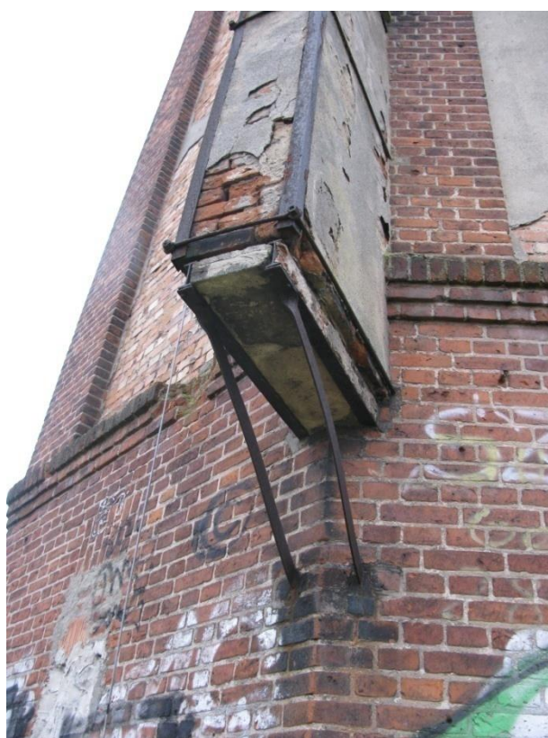
Zdjęcie 15 Uszkodzenie elewacji przez konstrukcję komina
