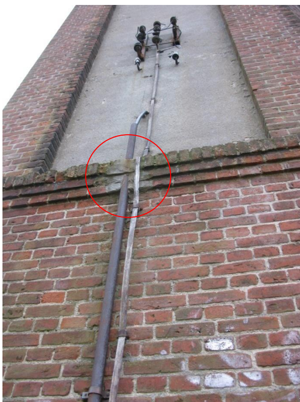
Zdjęcie 7 Ubytki w ceglany gzymsie powstałe w wyniku zamontowania na elewacji instalacji elektroenergetycznej
