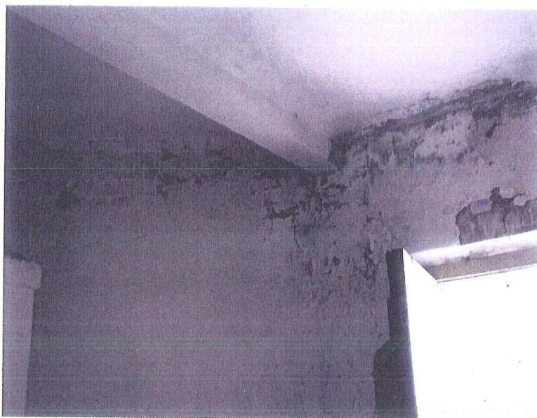
fot.35. Trzon wieży – I kondygnacja (parter). Na ścianie zachodniej ciemne ślady zawilgocenia.
