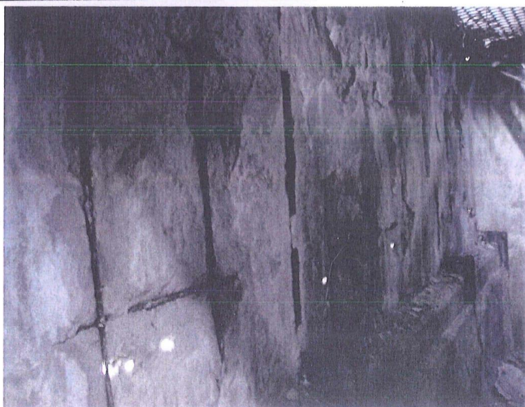
fot.22. Dolna partia ścian głowicy wieży. Widoczne ciemne ślady zawilgoceń oraz odspojona otulina prętów zbrojenia. Pręty pionowe \Phi 8 w rozstawie co 31-35 cm, a pręty poziome \Phi 6 w rozstawie co 50 cm. Pręty zbrojenia są ułożone w odległości ~20-25 mm od wewnętrznego lica ścian. Tak znaczny rozstaw prętów kwalifikuje ścianę jako betonową zbrojoną, a nie żelbetową.
