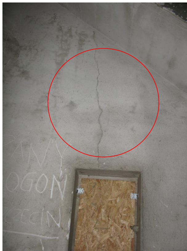
Zdjęcie 30 Pęknięcia w tynkach
