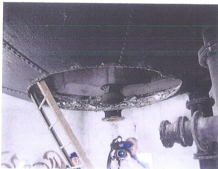
fot.6. Zbiornik stalowy na wodę posadowiony na koronie ścian trzonu wieży, w widoku na V kondygnacji. W dnie zbiornika został wycięty otwór o średnicy ~1,60 m. Zbiornik jest wykonany z blachy o grubości 6,5 mm, od góry otwarty, o połączeniach blach oraz połączeniach z elementami posadowienia za pomocą nitów.
