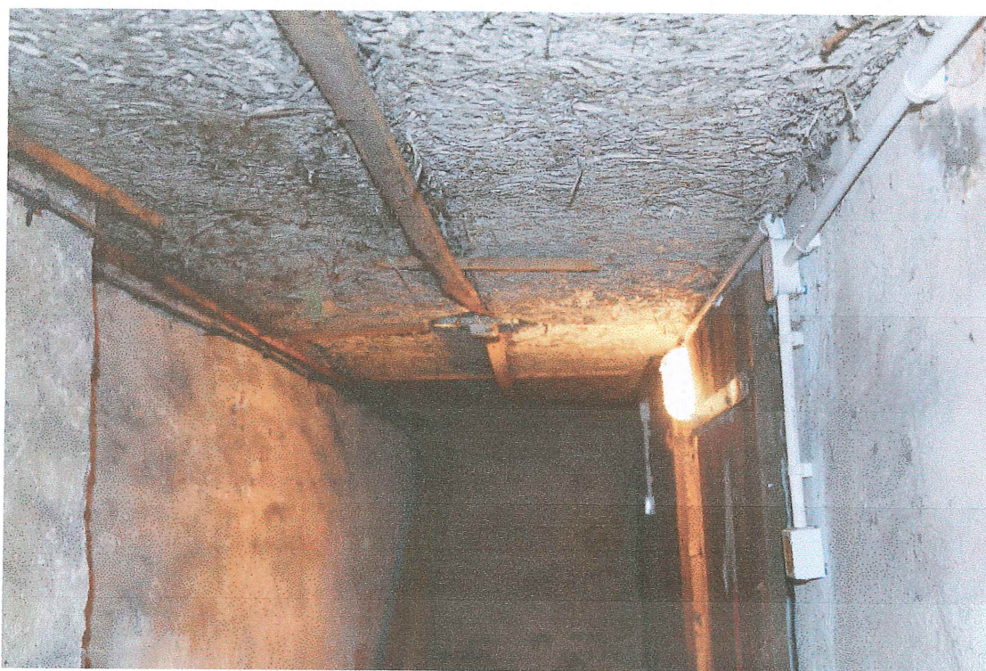
Zdjęcie nr 8 Fragment piwnicy, „docieplonej” płytą wiórową
