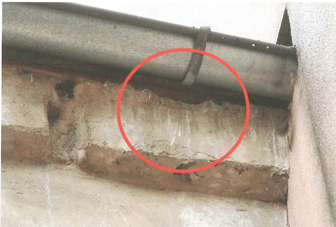
Zdjęcie nr 9 Widok na fragment stropodachu od strony pln-wsch – widoczne liczne ślady bytności ptaków (zabrudzenia odchodami), świadczące o wykorzystywaniu tych miejsc jako schronienia zimowe oraz miejsca lęgowe
