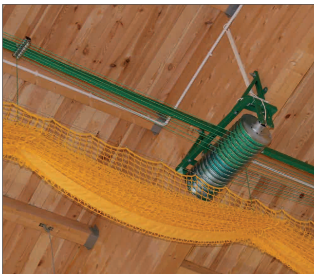
Zespół silnika do podnoszenia materiału kotary
