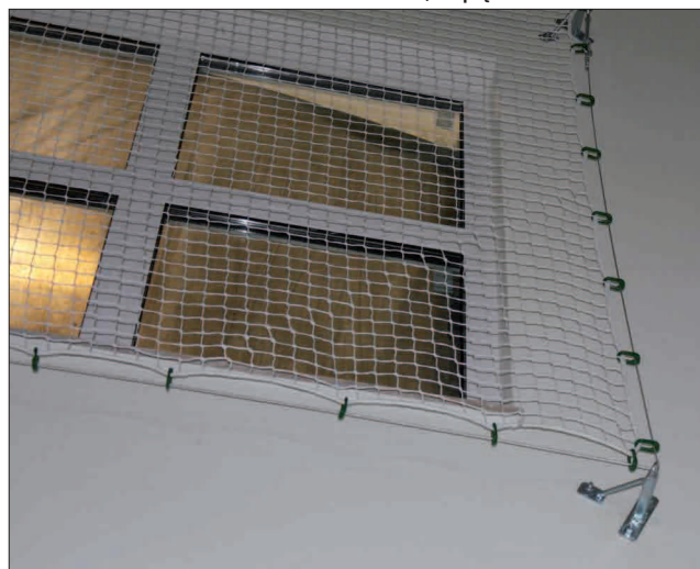
Siatki ochronne na okna, napięte
