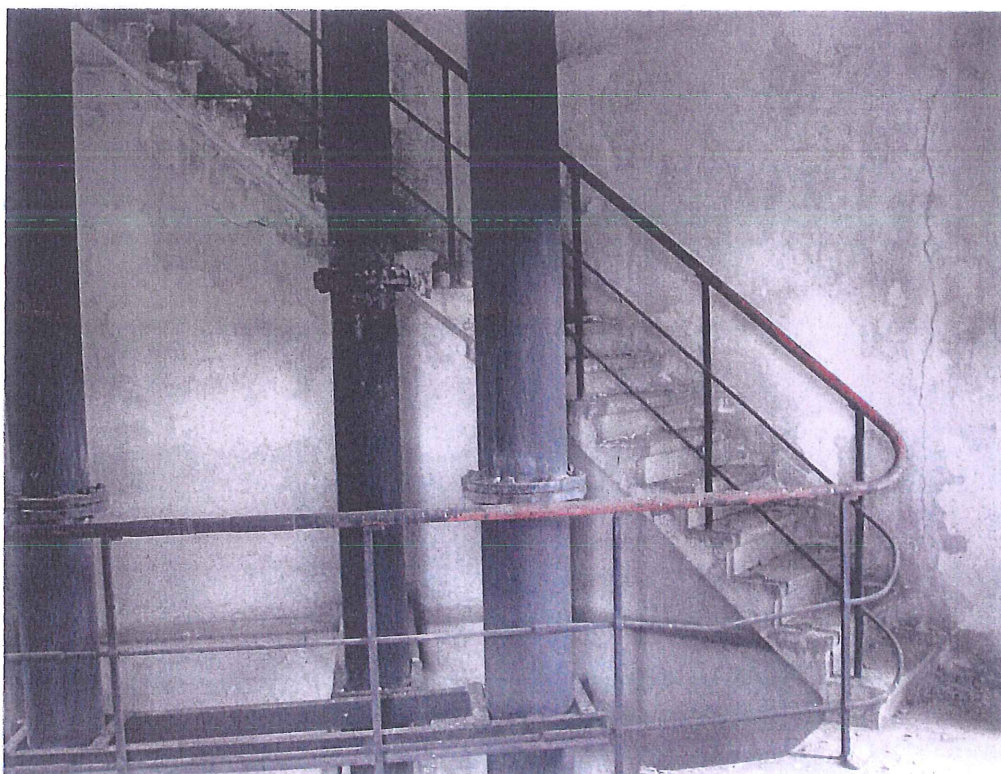
fol.30. Trzon wieży – III kondygnacja. Na ścianie południowo-wschodniej widoczne pionowe zarysowanie o niewielkiej rozwarłości. Schody 3-biegowe o stopniach wspornikowych żelbetowych prefabrykowanych. W schodach nieliczne uszkodzenia z ubytkami naroży stopnic.
