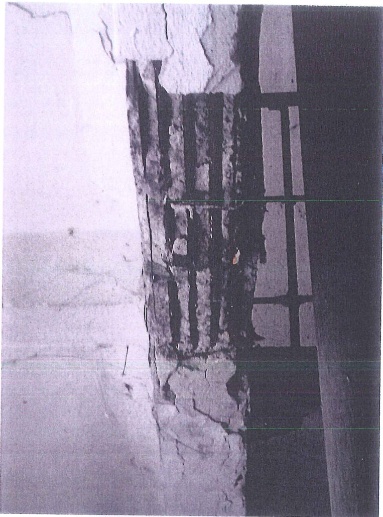
fot.37. Trzon wieży – I kondygnacja (parter). Podciąg stropu żelbetowego nad I kondygnacją - zbliżenie z fot.36. Widoczny rozległy ubytek otuliny, pręty zbrojenia głęboko skorodowane.
