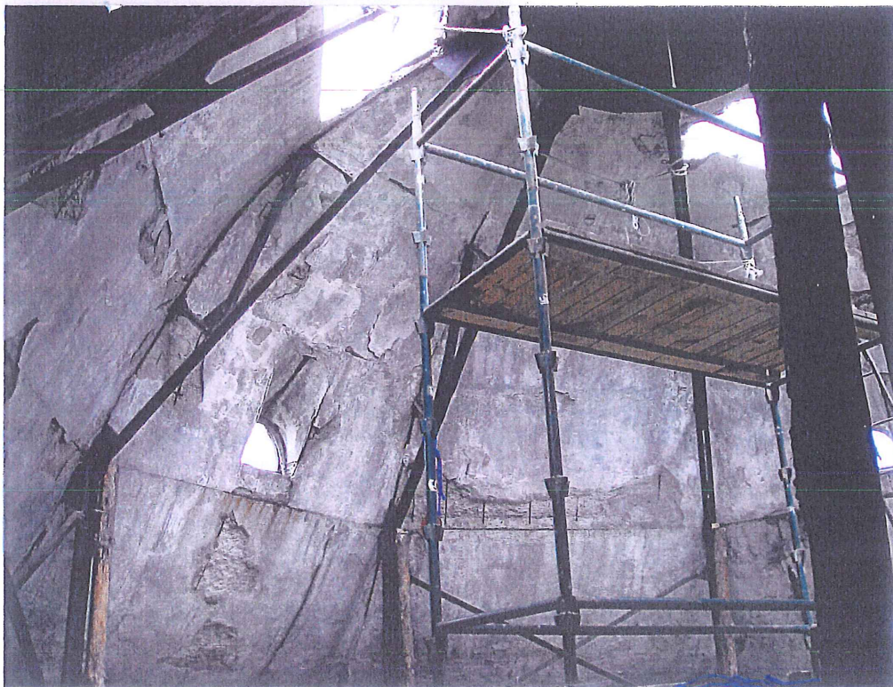
fot.8. Dach nad głowicą wieży. Widoczne wiązary stalowe nitowane, oparte na stalowych słupach, na których również jest oparty zbiornik. Słupy są posadowione na koronie ścian trzonu wieży, słupy są powierzchniowo skorodowane. Widoczne zniszczenia betonu zbrojonego.
