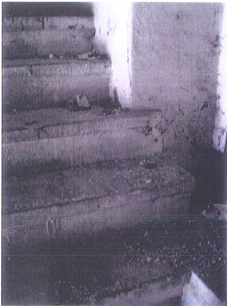
fot.39. Trzon wieży – I kondygnacja (parter). Fragment schodów przy ścianie wschodniej. Widoczne stopnie wspornikowe nie zamocowane w miejscu wnęki w ścianie.
