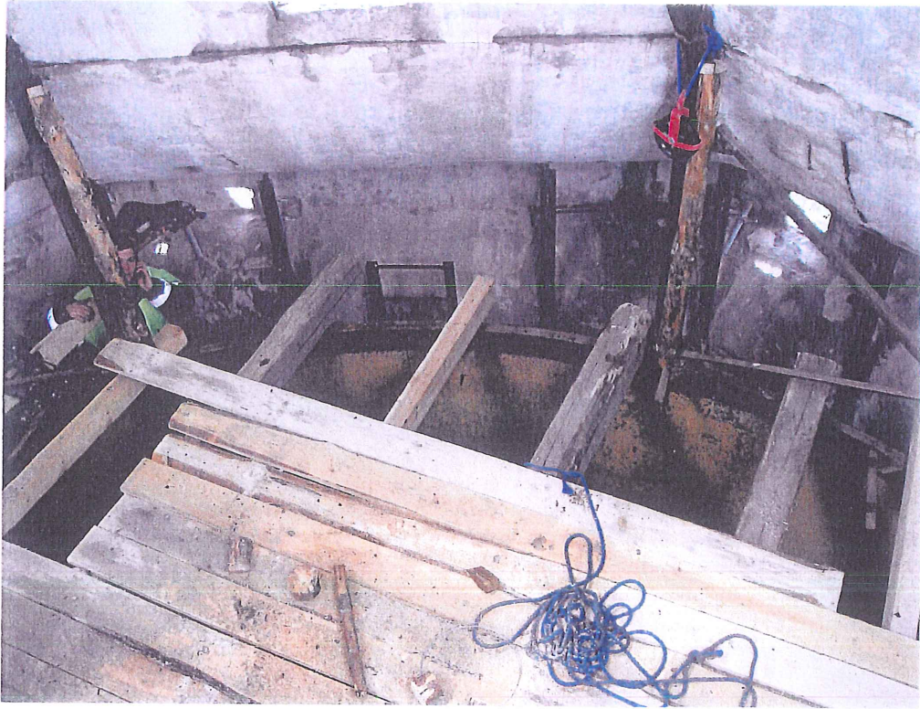
fot.5. Zbiornik stalowy na wodę w widoku z góry – widoczne powierzchniowe skorodowanie blach od strony wnętrza zbiornika. Na krawędziach zbiornika oparto belki niosące pomost drewniany, na którym stoi rusztowanie stalowe mające służyć pracom rozbiórkowym.
