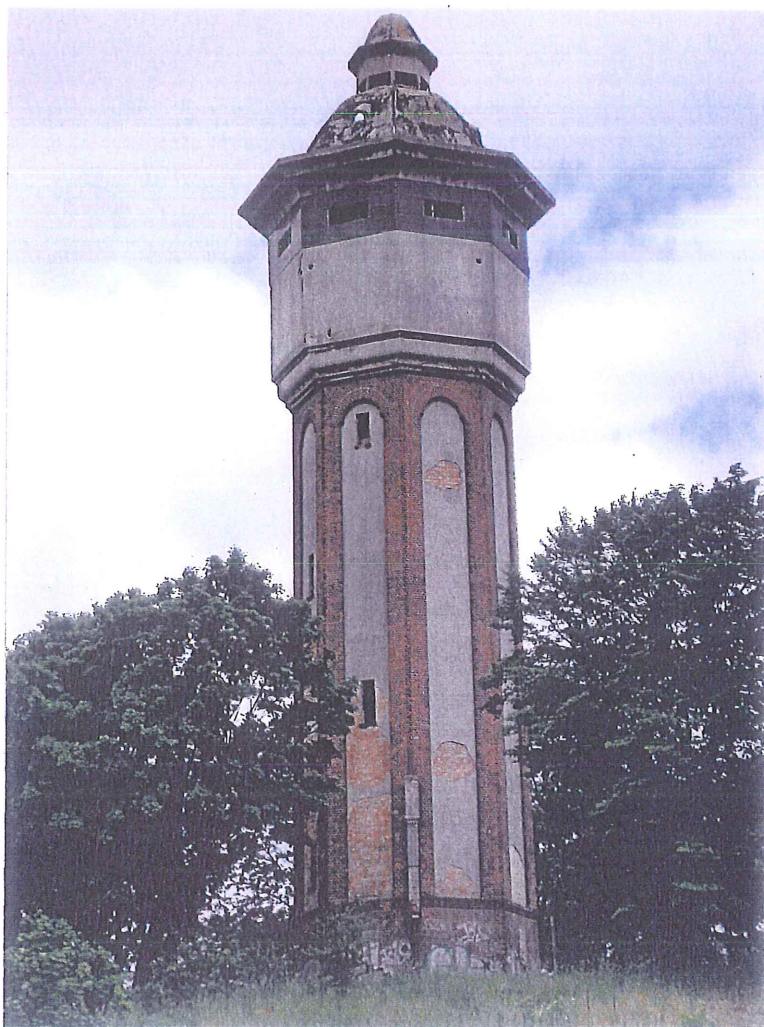
fot.2. Wodociągowa wieża ciśnień. W dolnej partii wieży trzon, w rzucie 8-boczny, murowany z cegły. Górą głowica wieży przewieszona wspornikowo, w rzucie 8-boczna, o konstrukcji wykonanej z elementów stalowych ze ścianami monolitycznymi ze zbrojonego betonu, mieszcząca stalowy zbiornik na wodę. Dach w rzucie 8-boczny, o płycie z monolitycznego betonu opartej na wiązarach stalowych. Nad dachem hełm z latarnią – niedostępny do badań.
