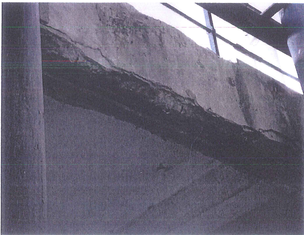
fot.34. Trzon wieży – II kondygnacja. Podciąg stropu żelbetowego nad II kondygnacją – zbliżenie z fot.33. Widoczny rozległy ubytek otuliny, pręty zbrojenia głęboko skorodowane.
