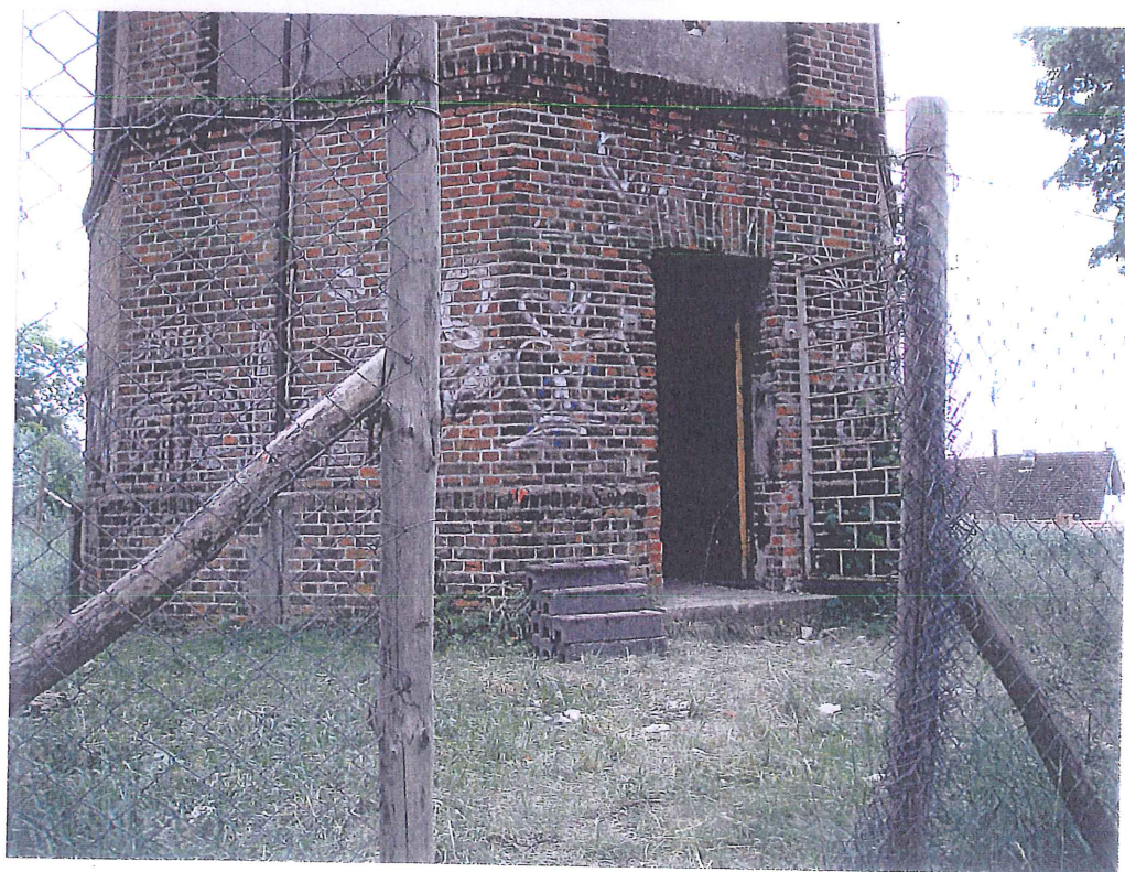
fot.4. Dolna partia trzonu wieży od strony północno-wschodniej. Widoczne wejście do wieży w ścianie wschodniej. Ściany trzonu wieży w tym poziomie o grubości 64 cm. W cokole występują nieliczne uszkodzenia z ubytkami poszczególnych cegieł.
