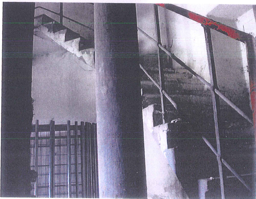
fot.38. Trzon wieży – I kondygnacja (parter). Schody 3-biegowe o stopniach wspornikowych żelbetowych prefabrykowanych. W schodach nieliczne uszkodzenia z ubytkami naroży stopnic.
