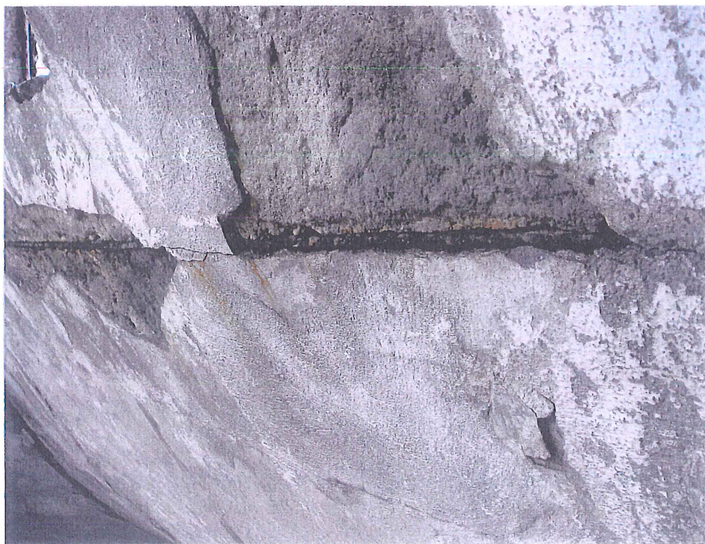
fot.14. Dach nad głowicą wieży – dolna partia. Fragment powłoki – widoczny ubytek otuliny i pręt zbrojenia całkowicie skorodowany.
