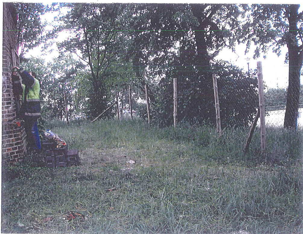
fot.44. Prowizoryczne ogrodzenie wieży z siatki stalowej na słupach drewnianych. Ogrodzenie jest wykonane wokół wieży w odległości ~4,70-5,20 m od ścian wieży.
