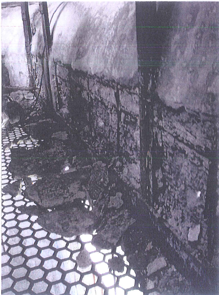
fot.16. Górna partia ścian głowicy wieży. Widoczna powłoka z betonu zbrojonego głęboko skorodowana, z rozległymi ubytkami warstw od strony wnętrza wieży. Elementy stalowe nośne skorodowane powierzchniowo, a pręty zbrojenia betonu głęboko skorodowane.
