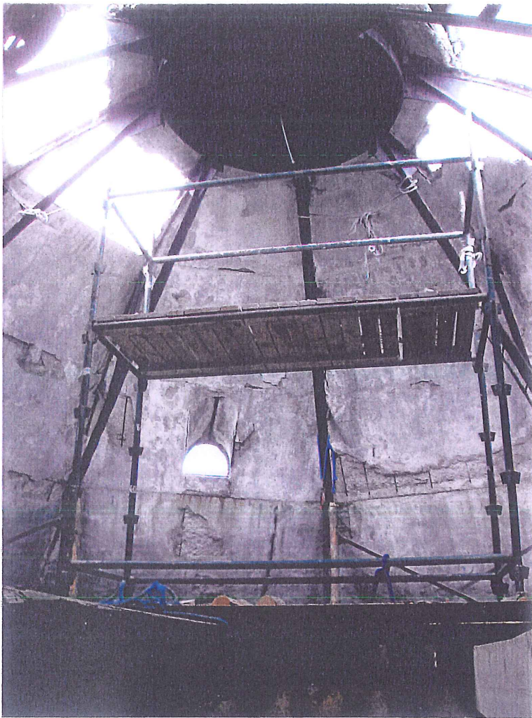
fot.7. Dach nad głowicą wieży. Widoczne wiązary stalowe niosące stalowy element centralny, na którym jest posadowiony hełm z latarnią. Powłoka dachu jest wykonana z betonu zbrojonego.
