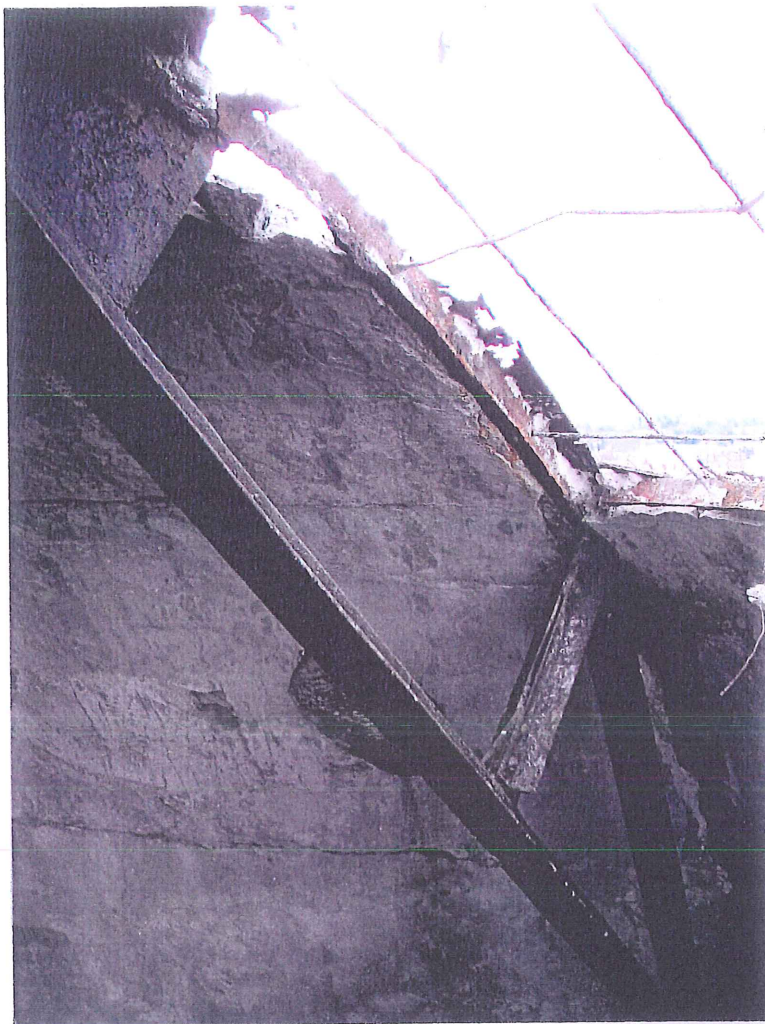
fot.11. Dach nad głowicą wieży. Fragment wiażara dachu – pas górny jest całkowicie skorodowany z ubytkami, pozostałe elementy wiażara są powierzchniowo skorodowane. Widoczny rozległy ubytek powłoki betonowej, pręty zbrojenia są głęboko skorodowane z ubytkami.
