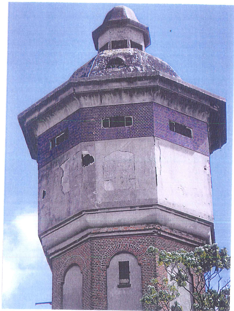
fot.3. Głowica wieży o ścianach z betonu zbrojonego grubości 5-6 cm, stanowiącego wypełnienie i usztywnienie elementów konstrukcji stalowej ścian i współpracującego w przenoszeniu obciążeń z tymi elementami.
