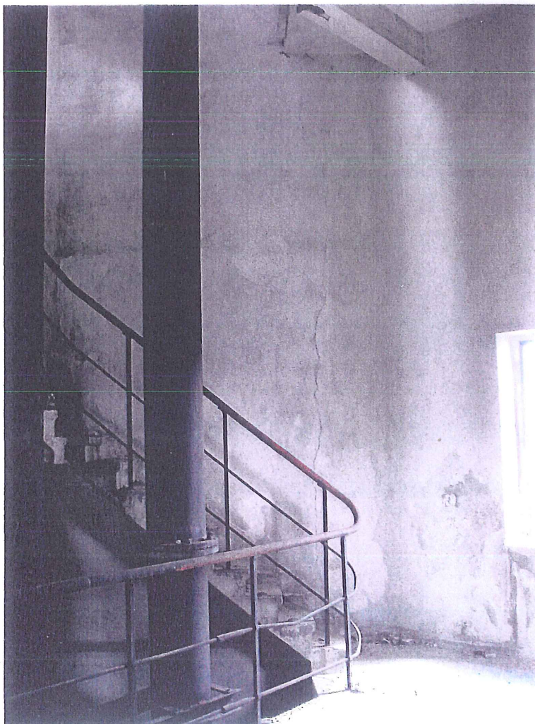
fot.28. Trzon wieży – III kondygnacja. Na całej wysokości ściany południowo-wschodniej pionowe zarysowanie o niewielkiej rozwarłości. Dołem w ścianie południowej ślady zawilgocenia.
