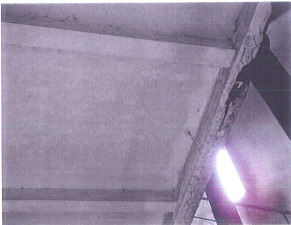
fol.29. Trzon wieży – III kondygnacja. Strop żelbetowy monolityczny nad III kondygnacją. W podciagu odspojona otulina, pręty zbrojenia są głęboko skorodowane.
